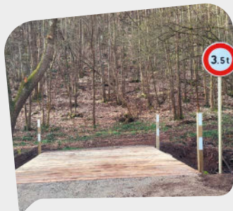
Réfection du pont lieudit Vorderer Wasserscheif. Travaux réalisés par TP Schmitt et LM Fer.
